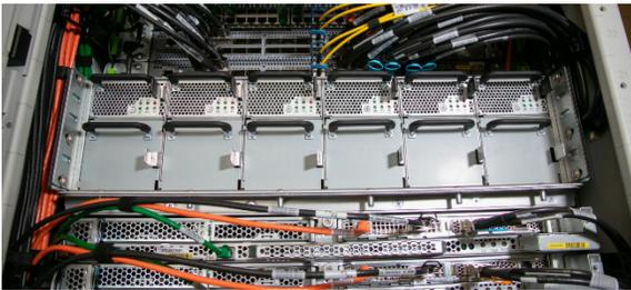
Abbildung 3: AWS Outposts AC-to-DC Stromversorgungen und Stromverteilung über Sammelschienen
