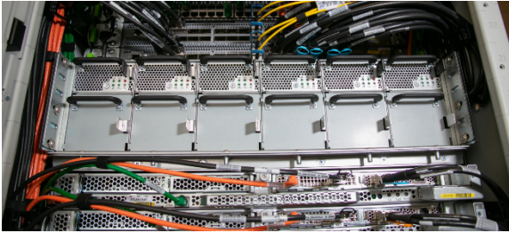
Figura 3: Fuentes de alimentación de AWS Outposts CA a CC y distribución de energía de barra colectora
